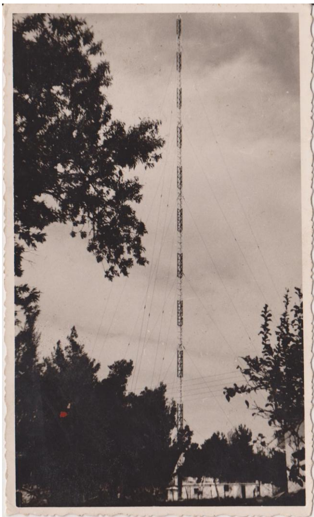
Η κεραία του σταθμού στον Ανεμόμυλο
